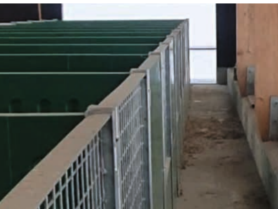
▲ Abb. 5: Boxen für junge Kälber sollten mindestens einen halben Meter von der Außenwand entfernt gesetzt werden, damit sich kalte Luft dort verteilt und nicht im Liegebereich der Tiere
