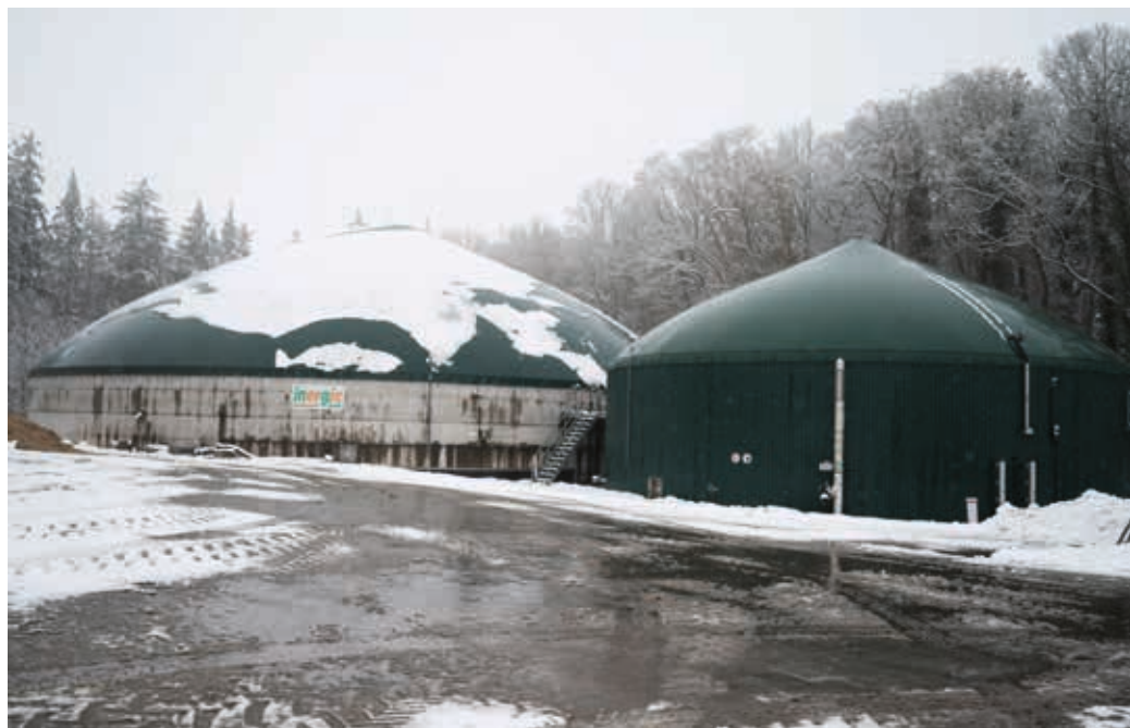
▲ Ein weiteres Standbein des Betriebes ist die Energieerzeugung. 2010 wurde die erste Dach-PV-Anlage in Betrieb genommen. 2016 wurde eine güllebasierte Biogasanlage mit 75 kW gebaut, 2019 eine weitere zusammen mit dem Stallbau. Inzwischen ist eine Freiflächen-PV-Anlage in Planung, die auf Moorflächen entsteht einschließlich Wiedervernässung.
