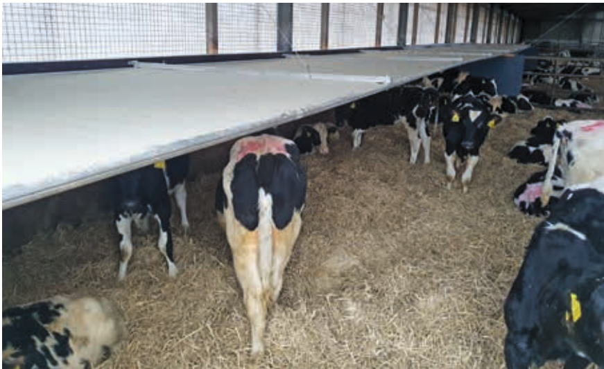
▲ Abb. 4: Ein Kälberhimmel verhindert, dass kalte Luft auf den Rücken der Kälber fällt und Wärme im Liegebereich nach oben hin entweicht
