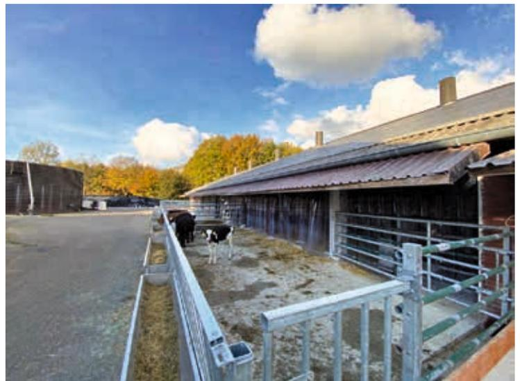
▲ Eine schöne Lösung für die Unterbringung älterer Kälber mit Außenklima fand dieser Betrieb aus dem Ammerland: Ein bereits bestehendes Gebäude wurde um einen Außenbereich/Laufhof mit zusätzlichem Fressbereich ergänzt. Der Zugang zum Außenbereich wird mit PVC-Lamellen gegen Zugluft von außen abgeschirmt. Im hinteren Liegebereich der Kälber wird durch die hochklappbare Zwischendecke aus Holz ein zusätzlich von oben zugluftgeschütztes Mikroklima erzeugt.
