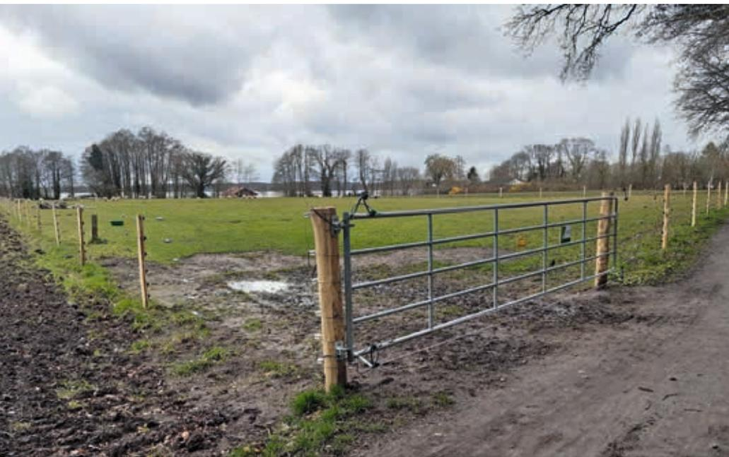
▲ Ein wolfsabweisender Stahldrahtzaun für Rinder mit Überkletter- und Untergrabeschutz am Weidetor
