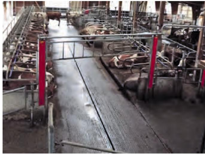
◀ Der Einbau von Hubtoren eignet sich besonders bei beengten Platzverhältnissen. Sie können manuell oder elektrisch angetrieben sein.
